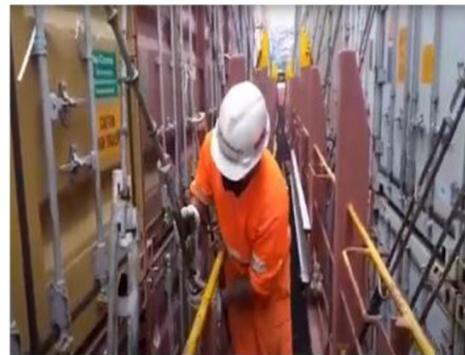
El trabajador engancha ambas estructuras metálicas y comienza a atornillarlas para que el enganche quede firme. Mientras las va girando se aprecian ambos hombros en flexión, flexión de ambos codos, supinación de antebrazo y flexo extensión de muñecas con fuerza.
