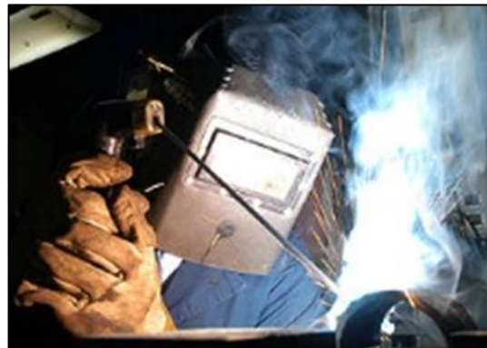
Figura 6. Soldadura al arco.
