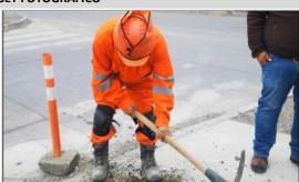
Se observa uso de picota. La toma con ambas manos, agarre con fuerza, abriendo un surco en donde colocará el moldaje. Realiza movimientos amplios de flexoextensión de codos. Sin uso de guantes.
