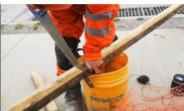
Se observa corte de molduras con serrucho. Sujeta la madera con mano izquierda en extensión y agarre con fuerza y corta con serrucho que manipula con la mano derecha. El serrucho se atasca al cortar, según indica el trabajador, porque la herramienta está muy gastada.
