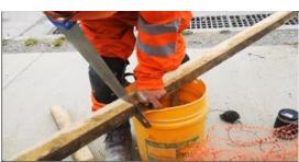
Se observa corte de molduras con serrucho. Sujeta la madera con mano izquierda en extensión y agarre con fuerza y corta con serrucho que manipula con agarre de la mano derecha. El serrucho se atasca al cortar, según indica el trabajador, porque la herramienta está muy gastada.
