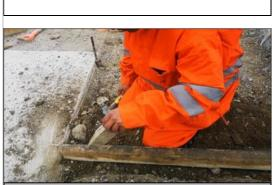
Se observa operación de fijar los moldajes con estaca de madera. Toma la estaca con la mano izquierda, sin uso de fuerza, postura neutra de muñeca, en el punto donde debe colocarla. Sin uso de guantes.
