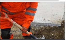
Se observa uso de pala para retiro de material suelto con picota. La toma con ambas manos en agarre con fuerza, muñecas con leve extensión, y movimientos de flexión de codos principalmente. Sin uso de guantes.
