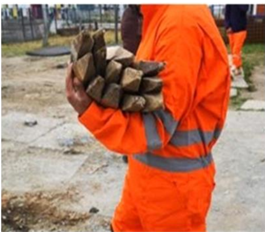
Se observa el transporte de las estacas de madera, con supinación de ambos antebrazos y flexión de ambos codos en 90° desde el camion hasta el lugar de acopio. Sin uso de guantes.
