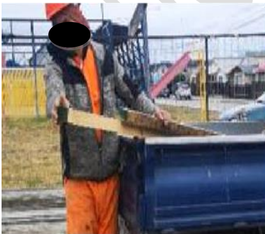
Se observa la carga de tablones desde el camión, para lo cual debe jalarlos con fuerza, ambas manos en agarre y codos extendidos. Sin uso de guantes.
