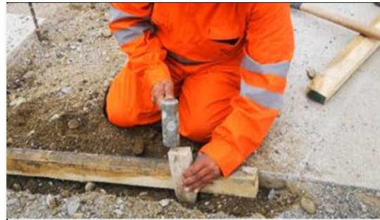
Continuación de lo anterior, golpea la estaca con combo que manipula con la mano derecha, mano izquierda que sujeta la estaca con postura neutra de muñeca y fuerza leve. Sin uso de guantes.
