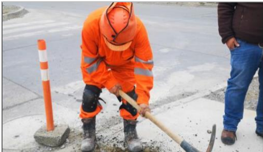
Se observa uso de picota. La toma con ambas manos, agarre con fuerza, abriendo un surco en donde colocará el moldaje. Realiza movimientos amplios de flexoextensión de codos. Sin uso de guantes.
