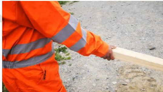
Acercamiento de la operación de nivelar el material de relleno.
