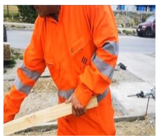
Se observa tablón retirado desde el camión, movimientos de flexión de codos, agarre con fuerza de ambas manos. Sin uso de guantes.
