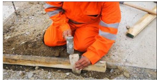
Continuación de lo anterior, golpea la estaca con combo que manipula con la mano derecha, mano izquierda sujeta la estaca con postura neutra de muñeca y fuerza leve. Sin uso de guantes.
