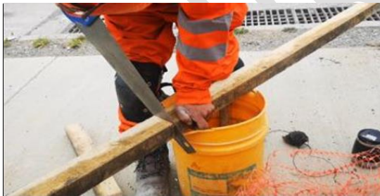
Se observa corte de molduras con serrucho. Sujeta la madera con mano izquierda en extensión y agarre con fuerza y corta con serrucho que manipula con agarre de la mano derecha. El serrucho se atasca al cortar, según indica el trabajador, porque la herramienta está muy gastada.
