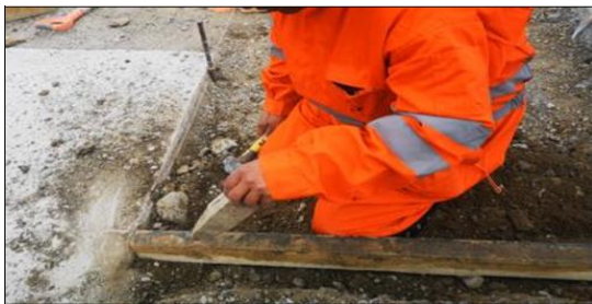
Se observa operación de fijar los moldajes con estaca de madera. Toma la estaca con la mano izquierda, sin uso de fuerza, postura neutra de muñeca, en el punto donde debe colocarla. Sin uso de guantes.
