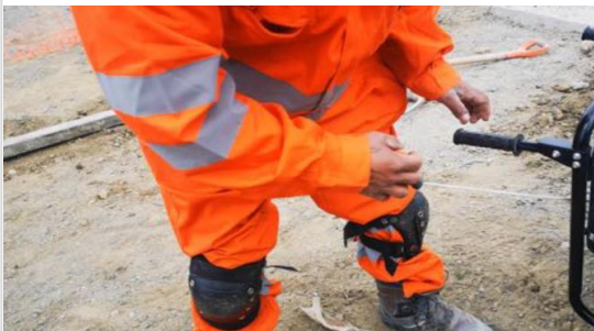
Finalmente el paciente compacta el material con máquina apisonadora, con agarre con fuerza de ambas manos. La máquina pesa 40 kilos, y funciona a motor diesel. Dado que cuando funciona vibra, el agarre se ve dificultado y requiere emplear más fuerza.
