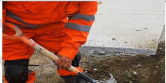
Se observa uso de pala para retiro de material suelto con picota. La toma con ambas manos en agarre con fuerza de mano derecha, muñecas con leve extensión, y movimientos de flexión de codos principalmente. Sin uso de guantes.
