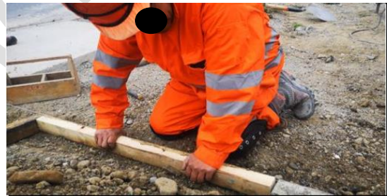
Se observa operación de colocar moldajes previamente cortados. Agarre con ambas manos, fuerza leve y postura de ambas muñecas en extensión. Sin uso de guantes.
