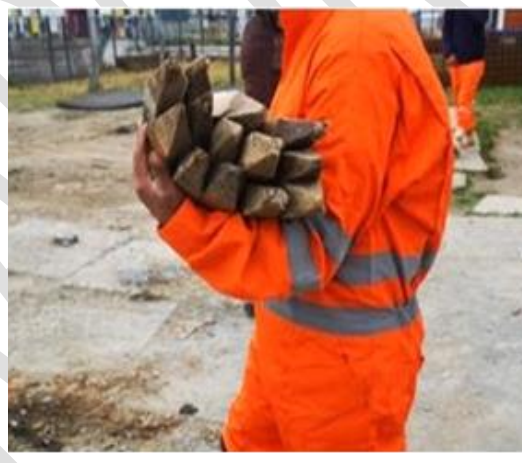
Se observa el transporte de las estacas de madera, con supinación de ambos antebrazos y flexión de ambos codos en 90° desde el camión hasta el lugar de acopio. Sin uso de guantes.
