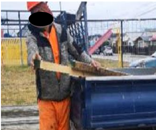
Se observa la carga de tablones desde el camión, para lo cual debe jalarlos con fuerza, ambas manos en agarre y codos extendidos. Sin uso de guantes.
