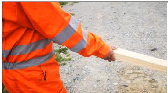
Acercamiento de la operación de nivelar el material de relleno.
