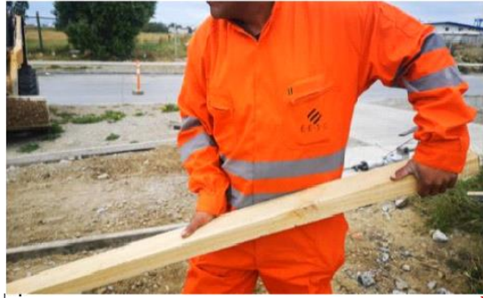
Se observa uso de niveladora manual de madera, la cual pasa por la superficie del material para emparejarlo. La toma con ambas manos en agarre, con flexión de muñeca y movimientos de flexoextensión de codos, en rango y frecuencia variable. Sin uso de guantes.
