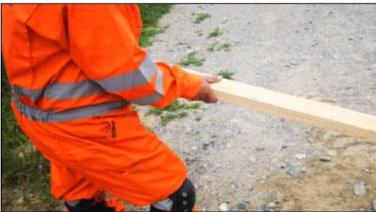
Posteriormente el trabajador nivela el material de relleno, con una apisonadora manual de madera. Toma la apisonadora manual con agarre con fuerza y la acerca hacia su cuerpo para ir nivelando la superficie, y posteriormente la aleja de su cuerpo.
