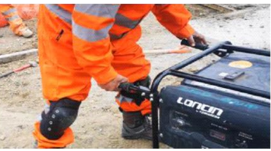
La operación se simuló con un generador, pues en ese momento no estaba disponible la máquina apisonadora.
