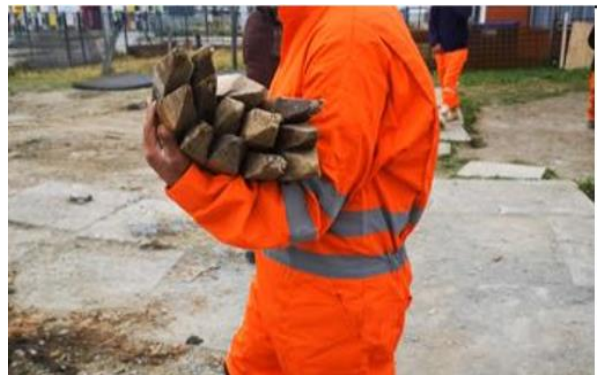
Se observa el transporte de las estacas de madera, con flexión de ambos codos en 90°, desde el camión hasta el lugar de acopio. Sin uso de guantes.
