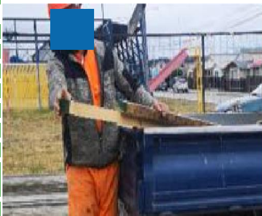
Se observa la carga de tablonés desde el camión, para lo cual debe jalarlos con fuerza, ambas manos en agarre y codos extendidos. Sin uso de guantes.
